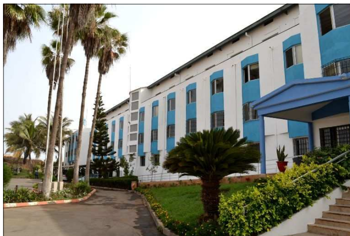
Nouveaux locaux du Bureau régional de l'UNESCO-BREDA Route de Ngor-Enceinte Hôtel Ngor Diarama
